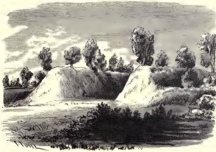
Terraplenes paralelos de Piketon
