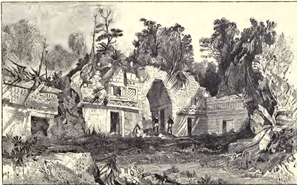
Interior del pórtico de Labná
