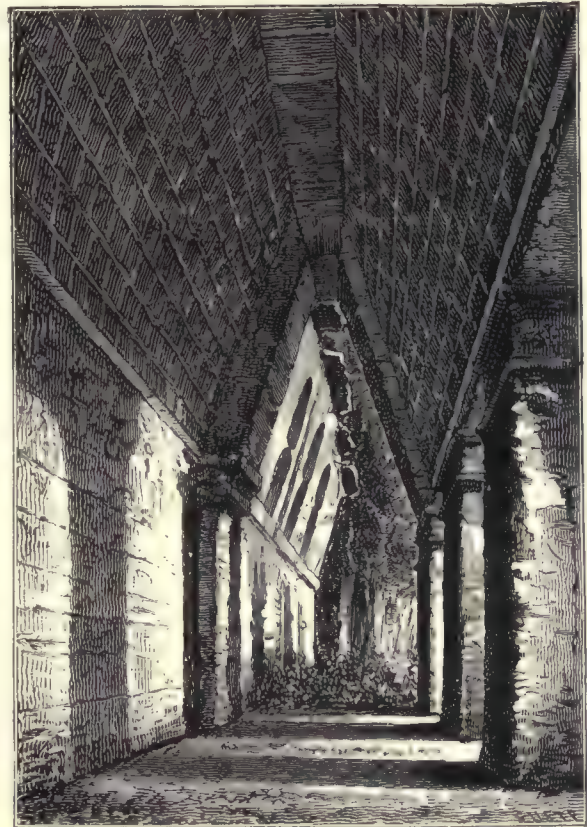
Interior de la galería del Palacio (De fotografía)
