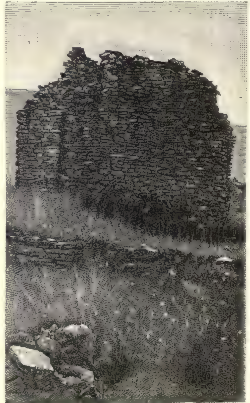
Trozo de muro en la Quemada
