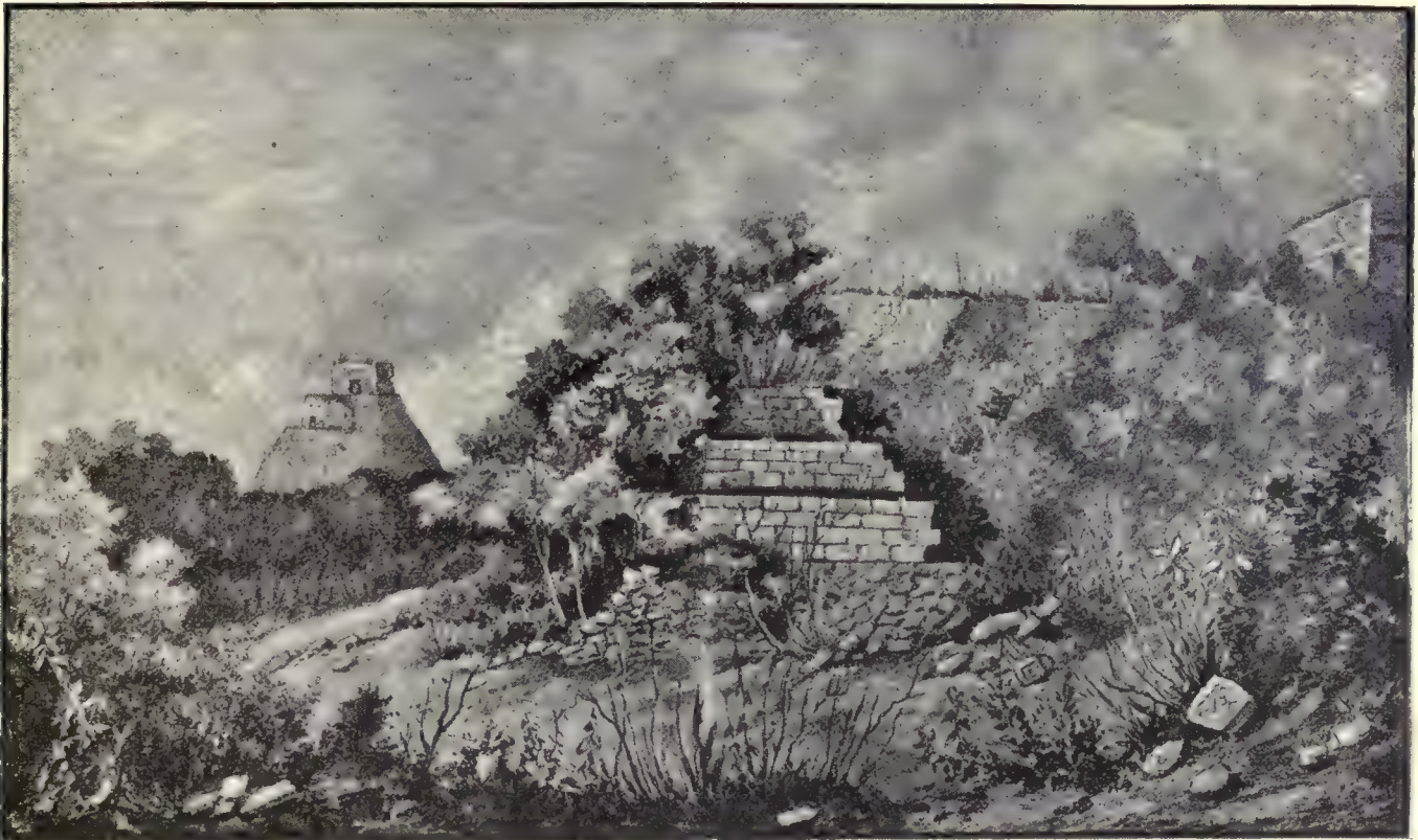
Palacio de Gobernador.—Vista al poniente
