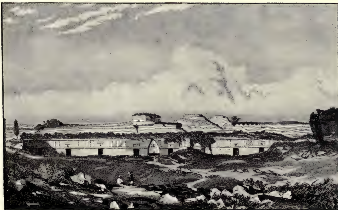
Fachada principal de la Casa de las Monjas
