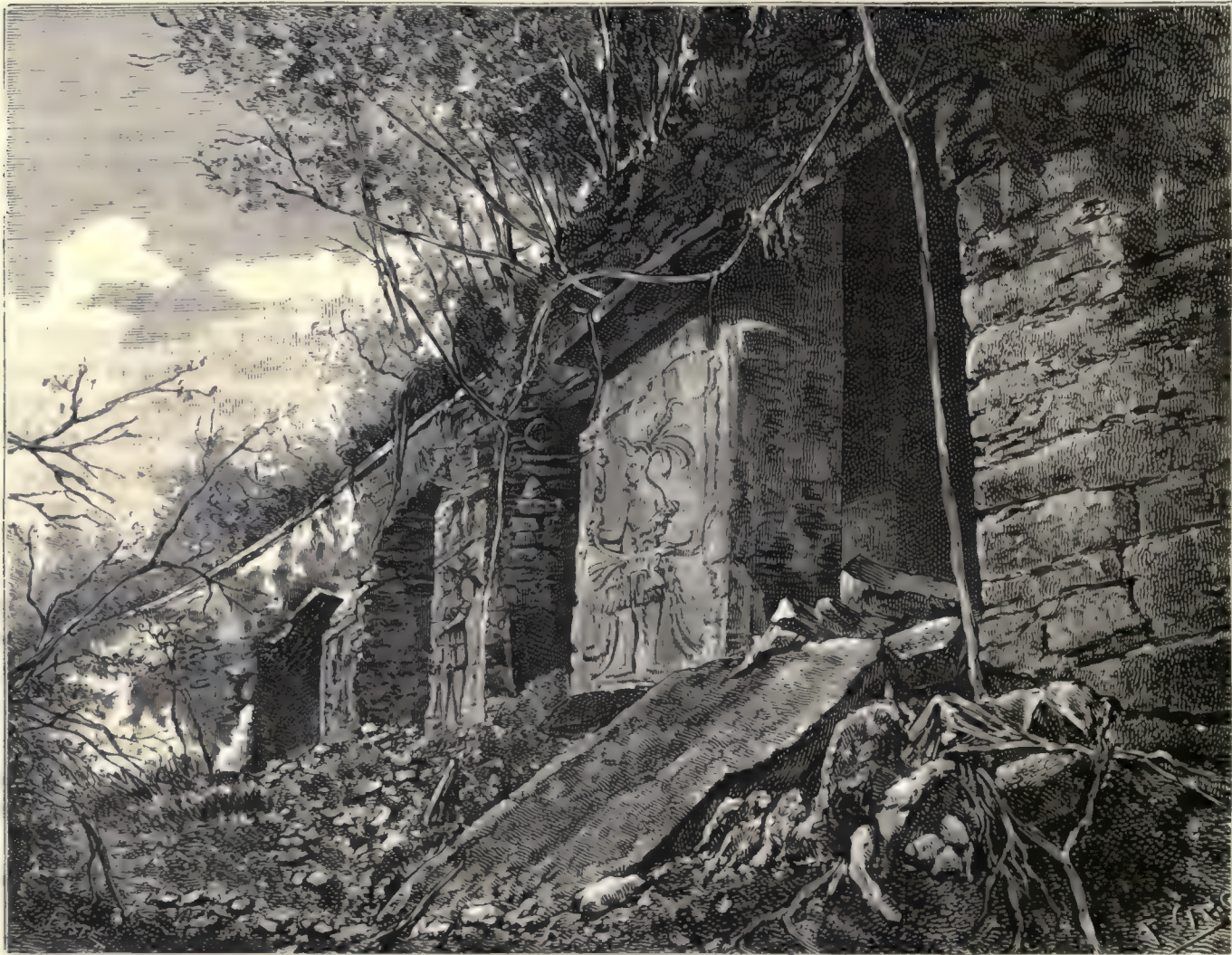
Vista del estado actual del templo de los Tableros
